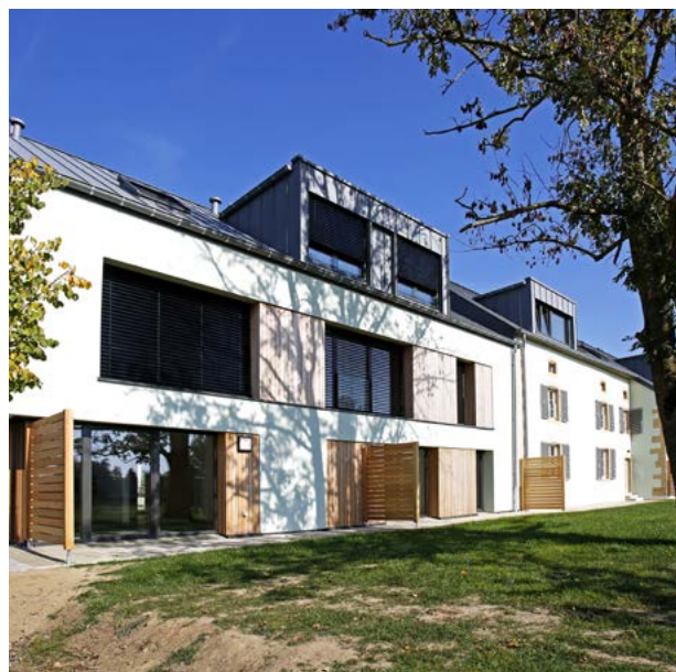
Huncherange - Fonds du Logement
